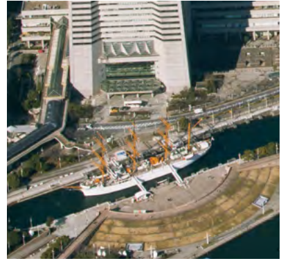
図 2-2-30 重要文化財旧横浜船渠株式会社第一号船渠
