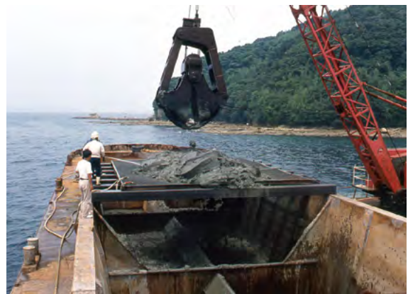
図 4-2-2 バケット付き台船を利用した掘削の例（鷹島海底遺跡）
