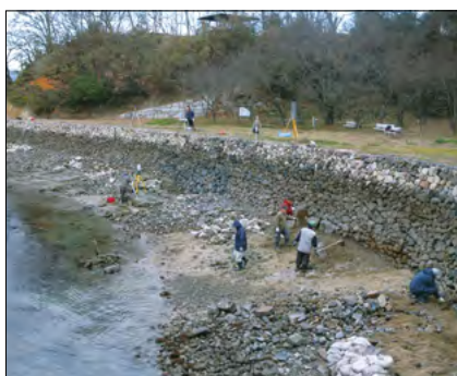
図 4-1-2 水位変動域の調査の例 （史跡能島城跡〈愛媛県〉）
