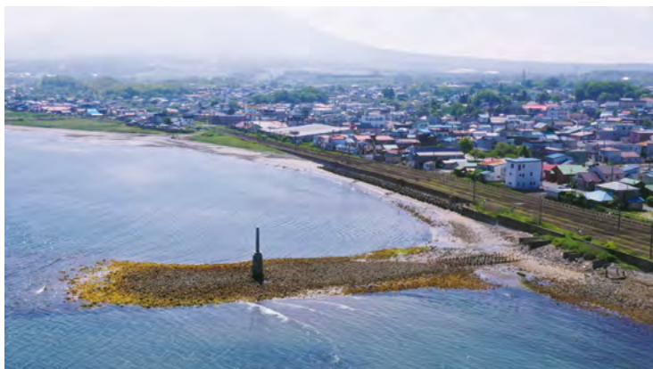
図 11-1 森棧橋跡俯瞰（北西から撮影）
