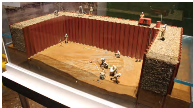
図 4-3-6 二重矢板囲い堰設置状況模型（滋賀県立琵琶湖博物館）
