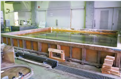
図 5-4-10 大型木材保管用の仮設プール
